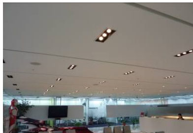
節電の取り組み 総使用電力量の削減
